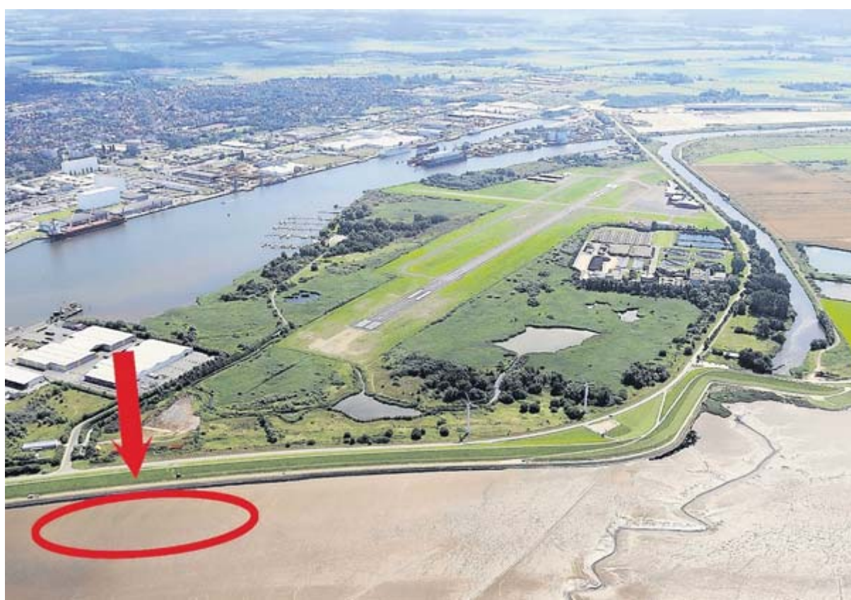
Hier soll der Offshore-Terminal Bremerhaven (OTB) entstehen. Weil die Kräne genau in Verlängerung der Landebahn stehen, wird der Flugplatz geschlossen.
