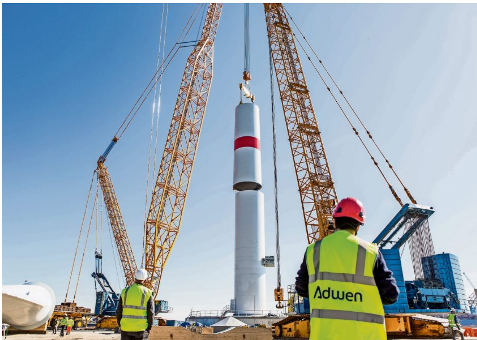
Bei idealem Wetter setzte der Riesenkran in dieser Woche die dritte von fünf Sektionen auf den Turm des Windradprototypen. Fotos Hanz/Adwen
