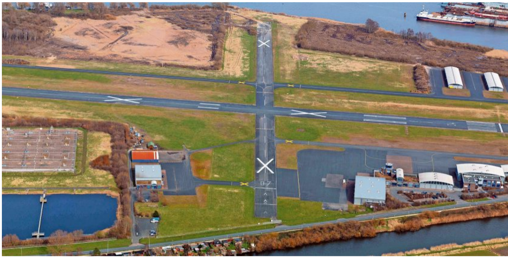
Auf dem Flugplatz Luneort geht nichts mehr: Keine Flüge, aber auch keine Nutzung als Offshore-Gewerbegebiet. Der Aero-Club hat gegen die Schließung geklagt, nun appellieren der Oberbürgermeister und der Wirtschaftssenator an die Flieger, sich der wirtschaftlichen Entwicklung nicht länger in den Weg zu stellen. Foto Scheer
