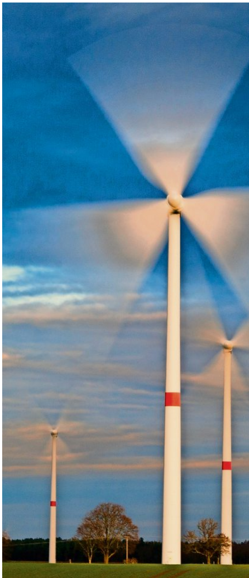
Eine Riesen-Windkraftanlage soll ab Mitte des Jahres zu Testzwecken auf dem inzwischen verwaisten Flugplatz Luneort gebaut werden. Aber weil der Aero-Club gegen die Schließung geklagt hat, untersagte das Obergericht alle baulichen Veränderungen. Erst wenn mit dem Bau des Offshore-Terminals begonnen wird, dürfe auch der Flugplatz geschlossen und anderweitig genutzt werden, sagten die Richter. Foto Pleul
