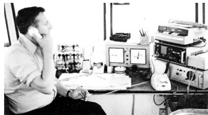
Ab 1964 wurde der Flugplatz kommerziell genutzt, die Rollbahn um 250 Meter auf 800 Meter erweitert, eine Wartehalle eingerichtet. 1966 kam der Tower dazu – Rolf Stenzel regelte dort den Luftverkehr. Fotos (2) privat
